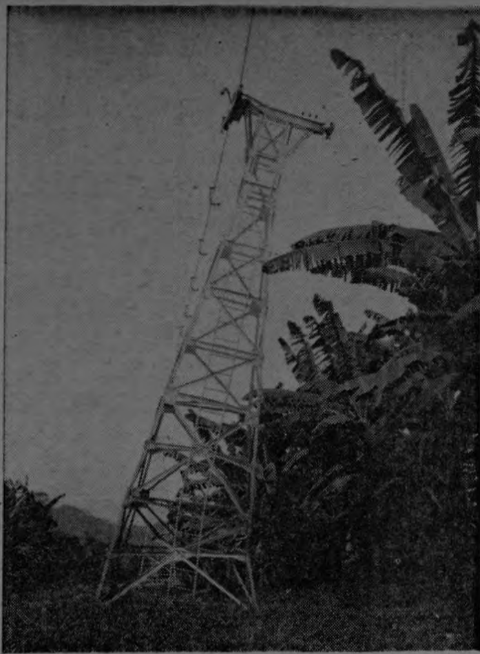
La famosa torre del andarivel de Webb, inclinada como la Torre de Pisa, quebrantada su basa por el fuerte impacto de las aguas turbulentas. Al fondo, otra de las pocas torres que quedaron en pie.
